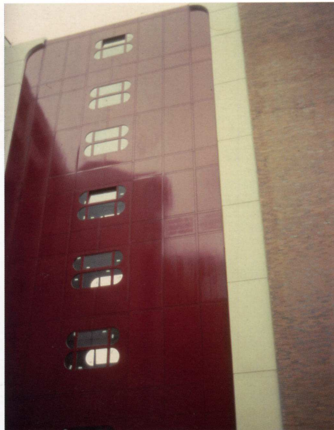
Темно-красные сэндвич-панели с большими частичными изменениями внешнего вида: появление матовости.
