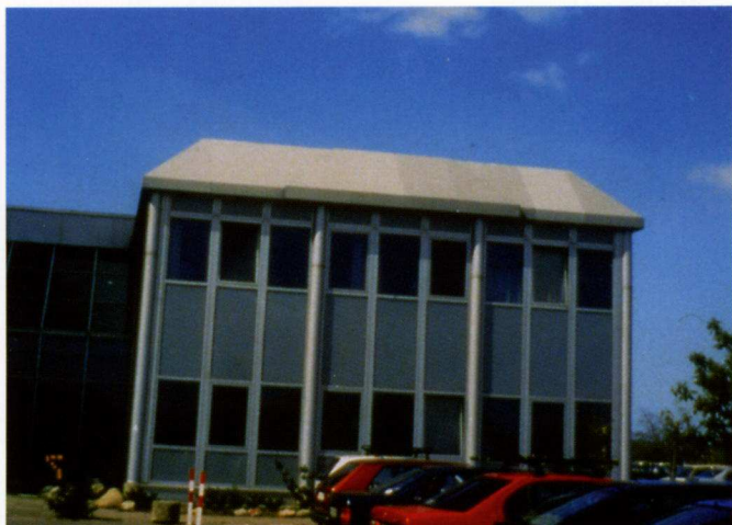
Пример недоотвержденного покрытия. Спустя полгода на покрытии появляются очевидные различия в цвете, происходит его выгорание
